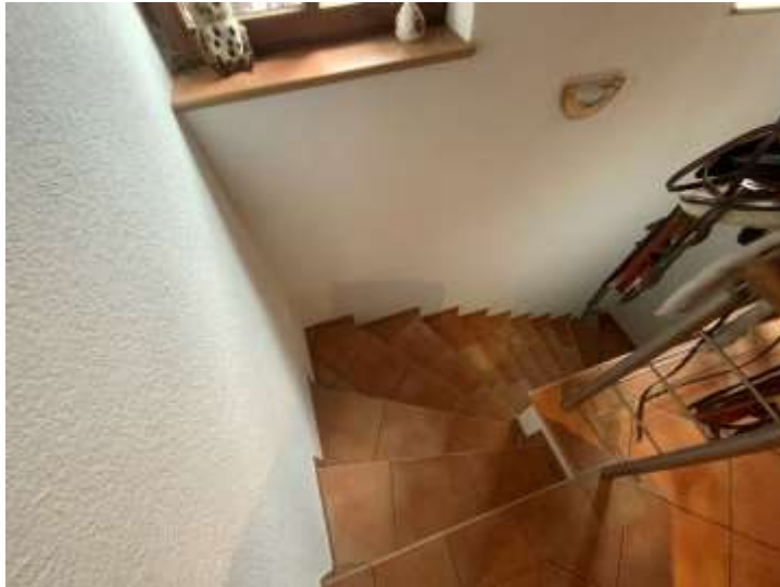
Bild 28: Treppe EG - UG
