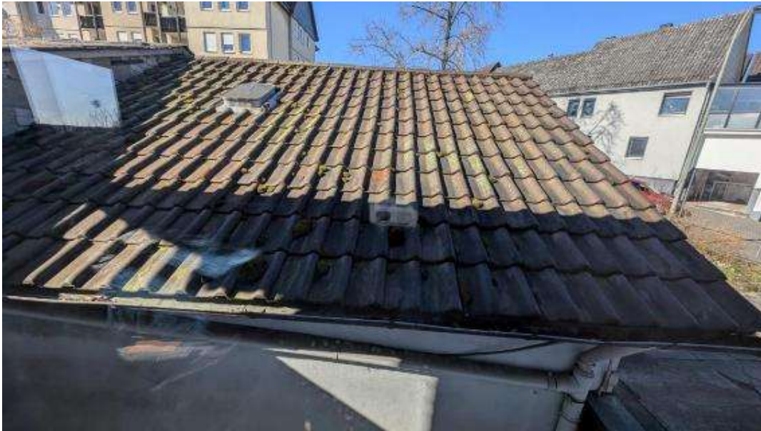
Bild B8 Dachansicht Garage
