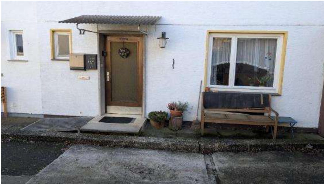
Bild B10 Eingangsbereich Wohnhaus
