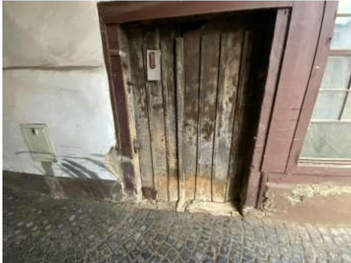
Bild 4: Zugang Wohnhaus seitlich
