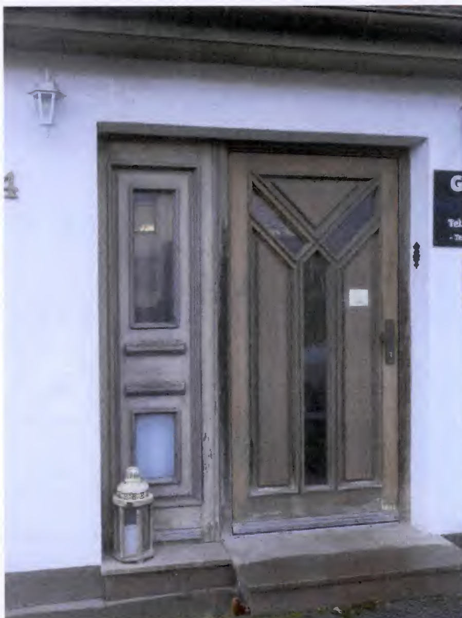
Bild 9: Eingangstür mit witterungsbedingten Schäden
