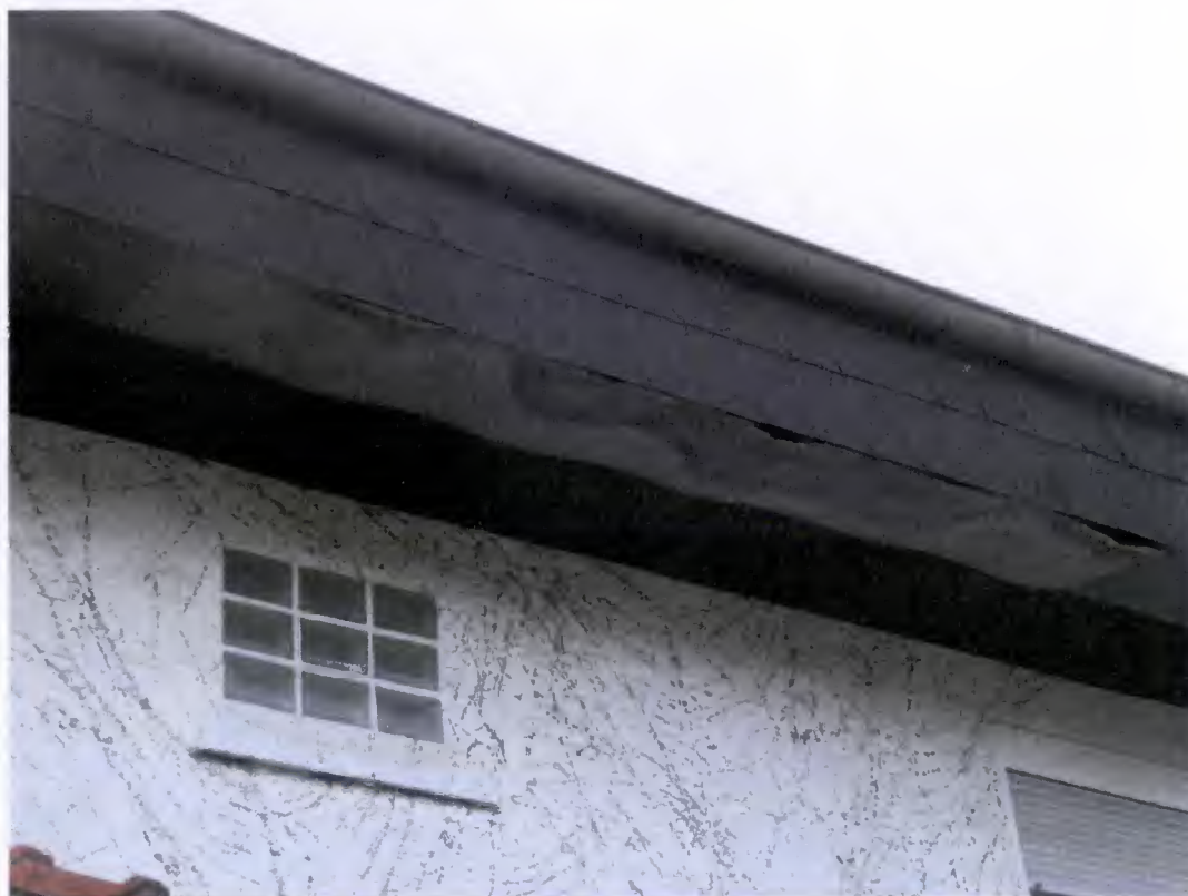
Bild 7: Feuchteschäden am traufseitigen Rinnkasten
