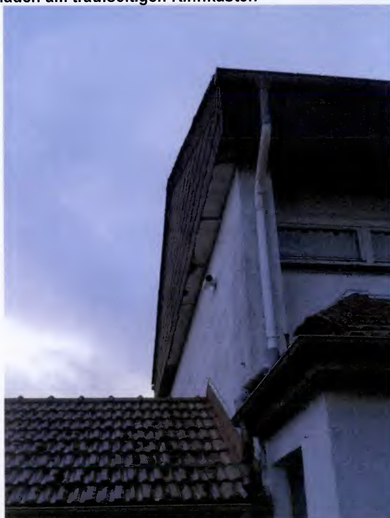
Bild 8: Feuchteschäden an der Giebelverkleidung
