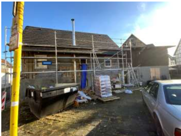
Bild 11: Wohnhaus I und Anbau
