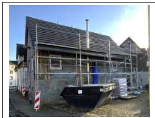
Abb.: Seitenansicht Wohnhaus (1)
