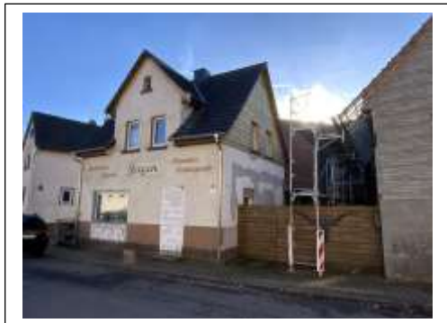
Abb.: Straßenansicht Wohnhaus (2)
