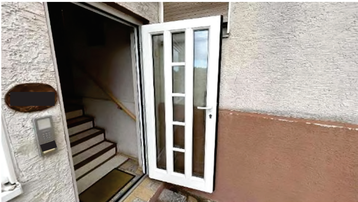
Bild B4 Eingangsbereich
