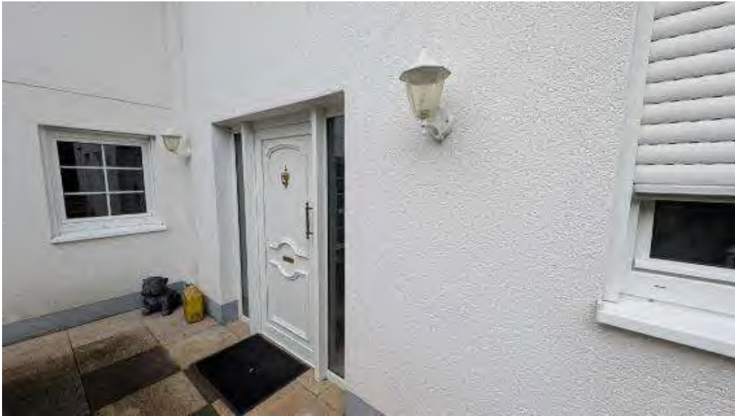
Bild B5 Eingangsbereich Untergeschoss
