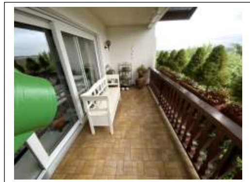
Abb.: Überdeckter Balkon
