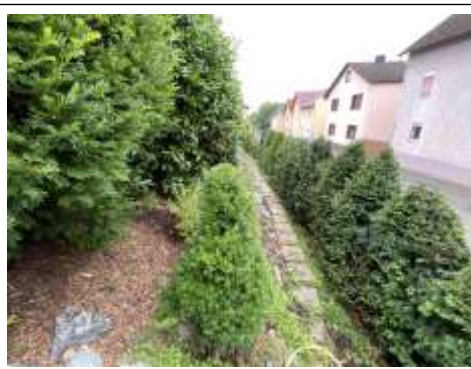
Abb.: unterer Grundstücksbereich mit Hang
