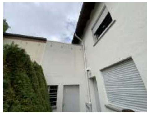
Abb.: Zugang Keller Garage
