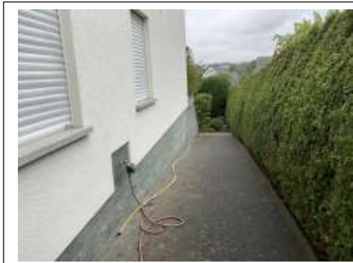
Abb.: Zugangsweg zu Keller Garage
