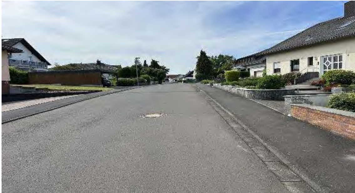
Bild A1 Blick in die Erschließungsstraße
