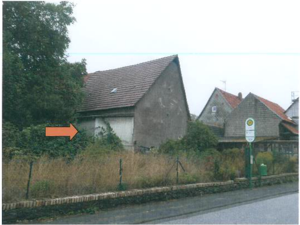
Bild 1, Halle, Ansicht Licher Straße von Süden
