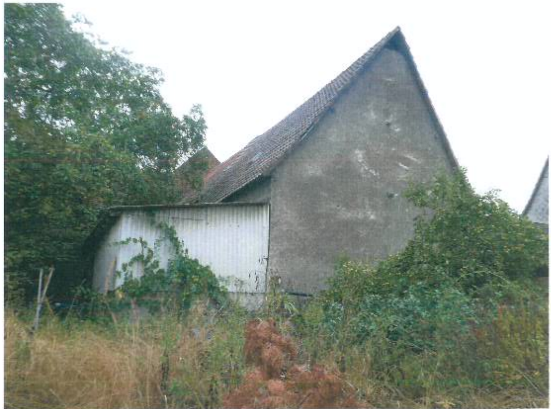
Bild 2, Halle, Ansicht von Süden
