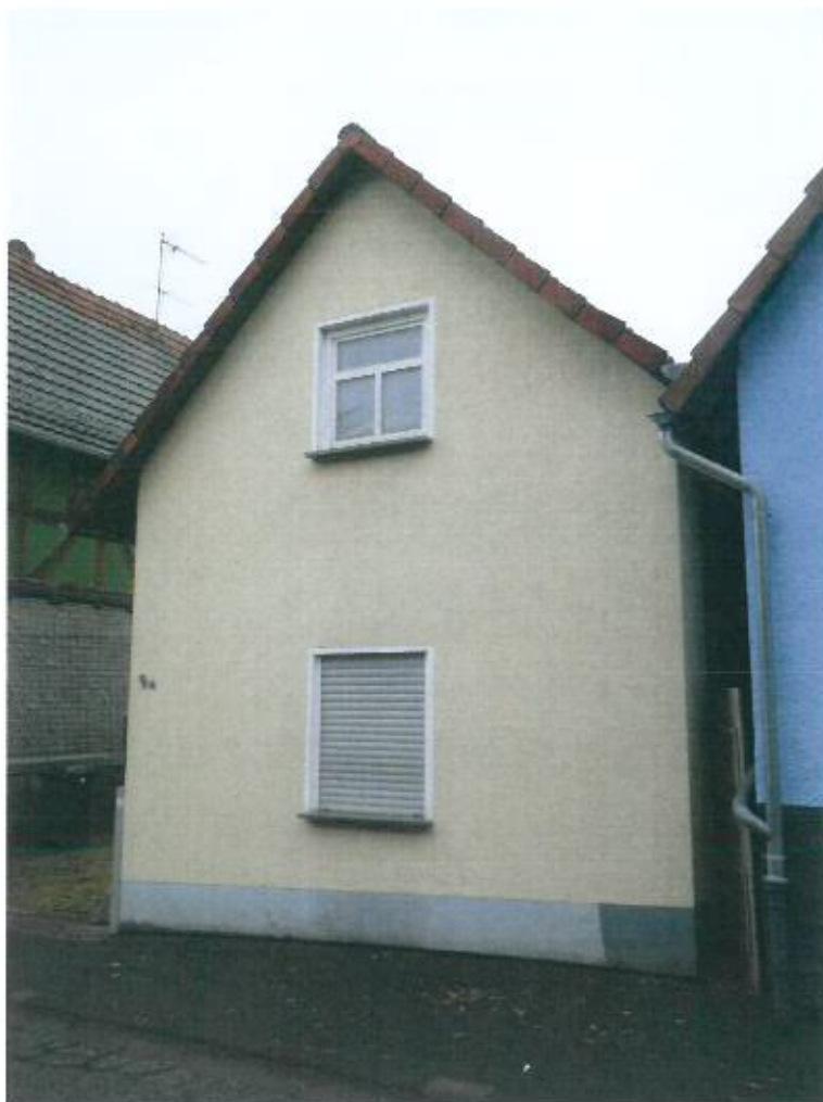
Bild 6, Nebengebäude, Straßenansicht von Norden
