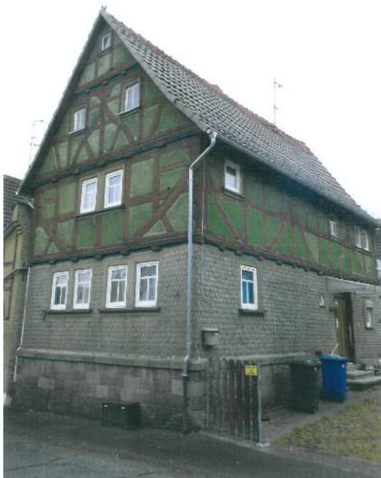
Bild 2, Wohnhaus, Straßenansicht von Norden
