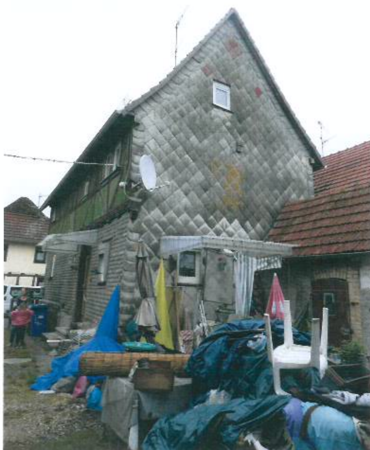
Bild 4, Wohnhaus, Hofansicht von Südwesten
