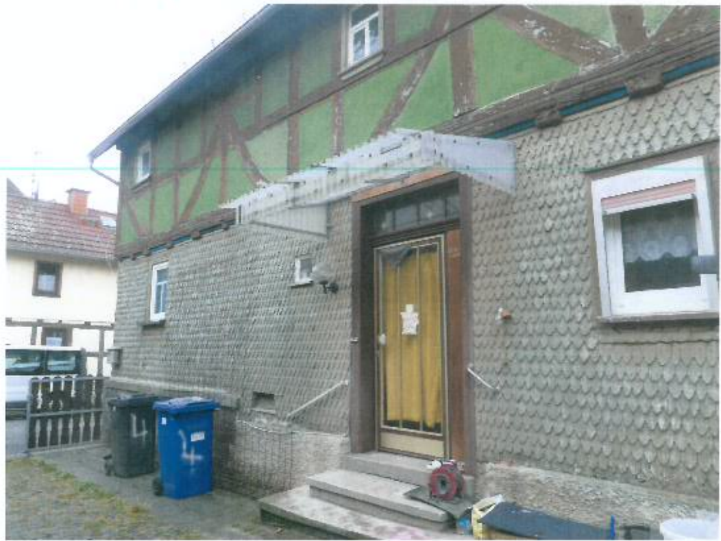
Bild 3, Wohnhaus, Hofansicht von Südwesten
