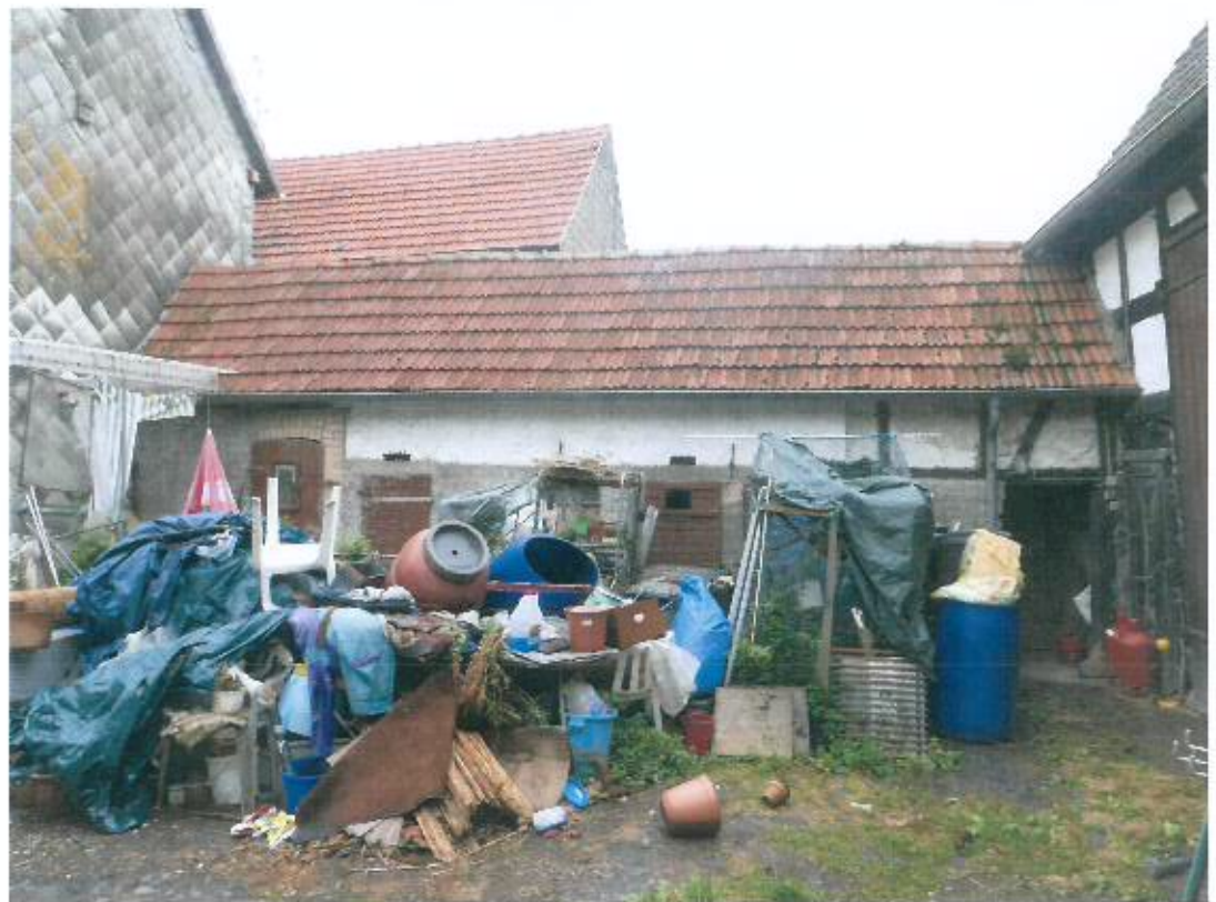
Bild 12, Stallgebäude, Hofansicht von Nordwesten
