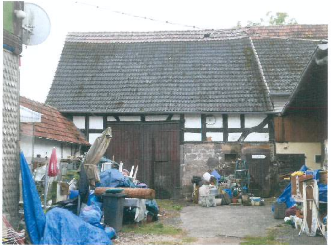
Bild 1, Scheune, Ansicht von Nordosten
