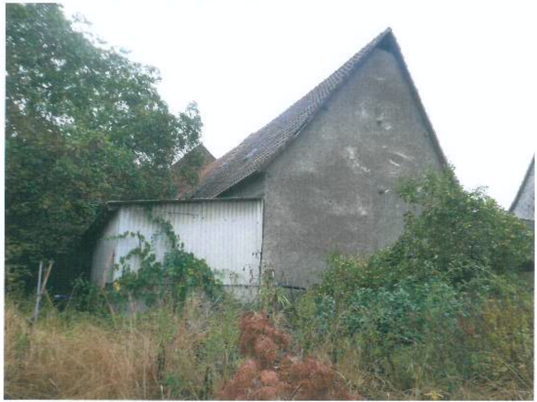
Bild 3, Scheune, Ansicht von Südosten
