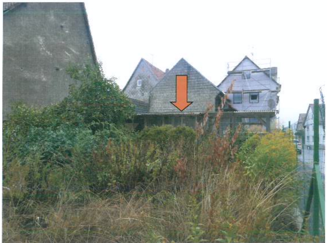
Bild 2, Schuppen, Ansicht von Südwesten
