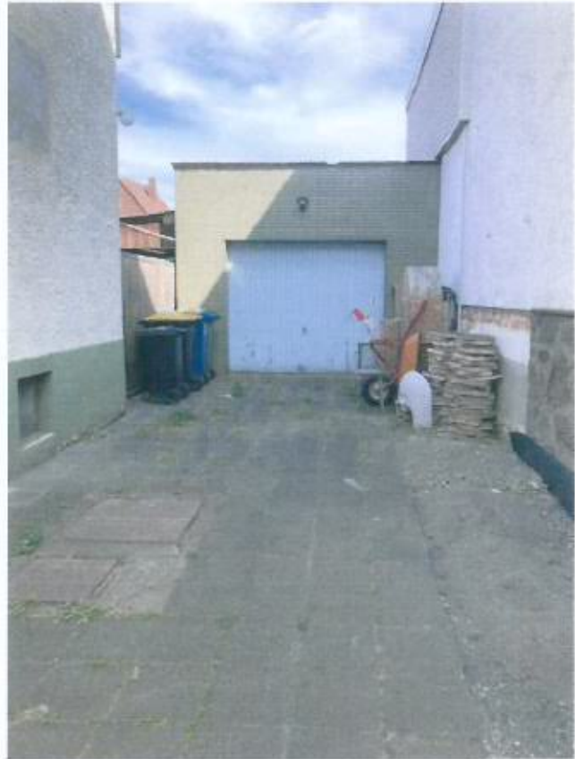
Bild 5: Garage, Hofansicht von Westen
