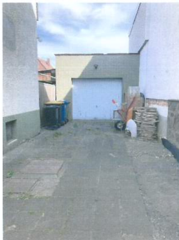
Garage, Ansicht von Westen
