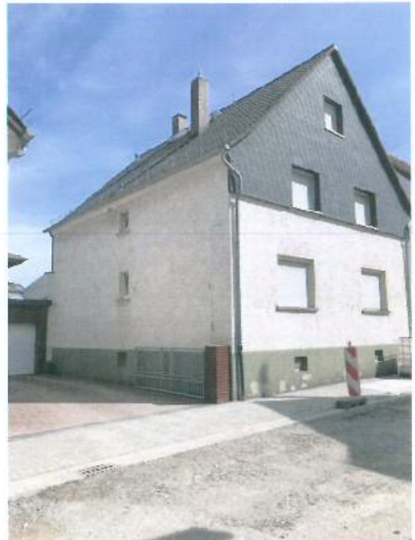
Straßenansicht von Nordwesten
