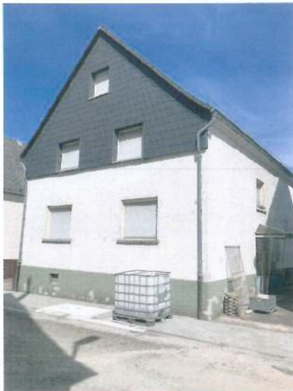
Straßenansicht von Südwesten
