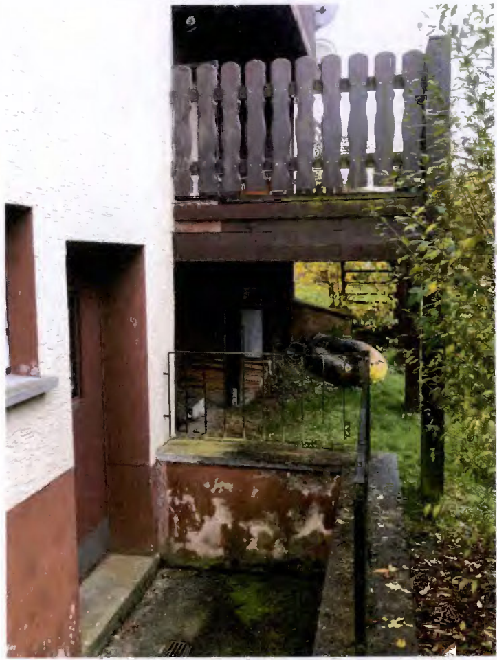
Bild 13 Kellerabgang, Feuchtigkeiten
