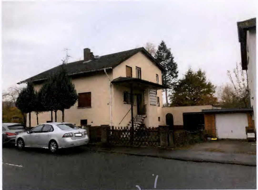
Bild 3: Straßenansicht von Nordosten
