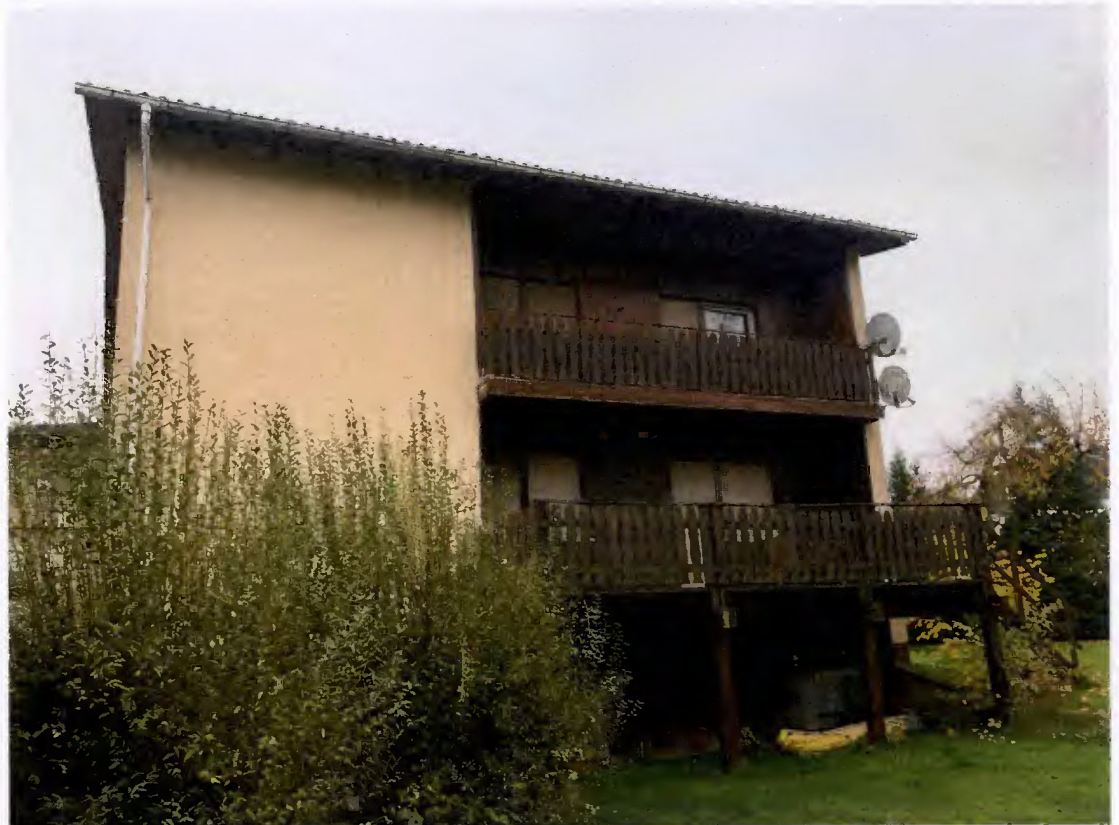
Bild 5 Gartenansicht von Westen
