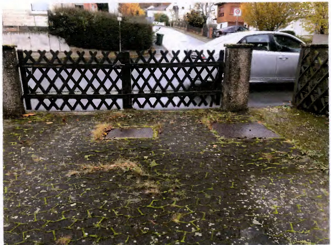
Bild 14 Hoffläche mit Setzungen und Einwachsungen
