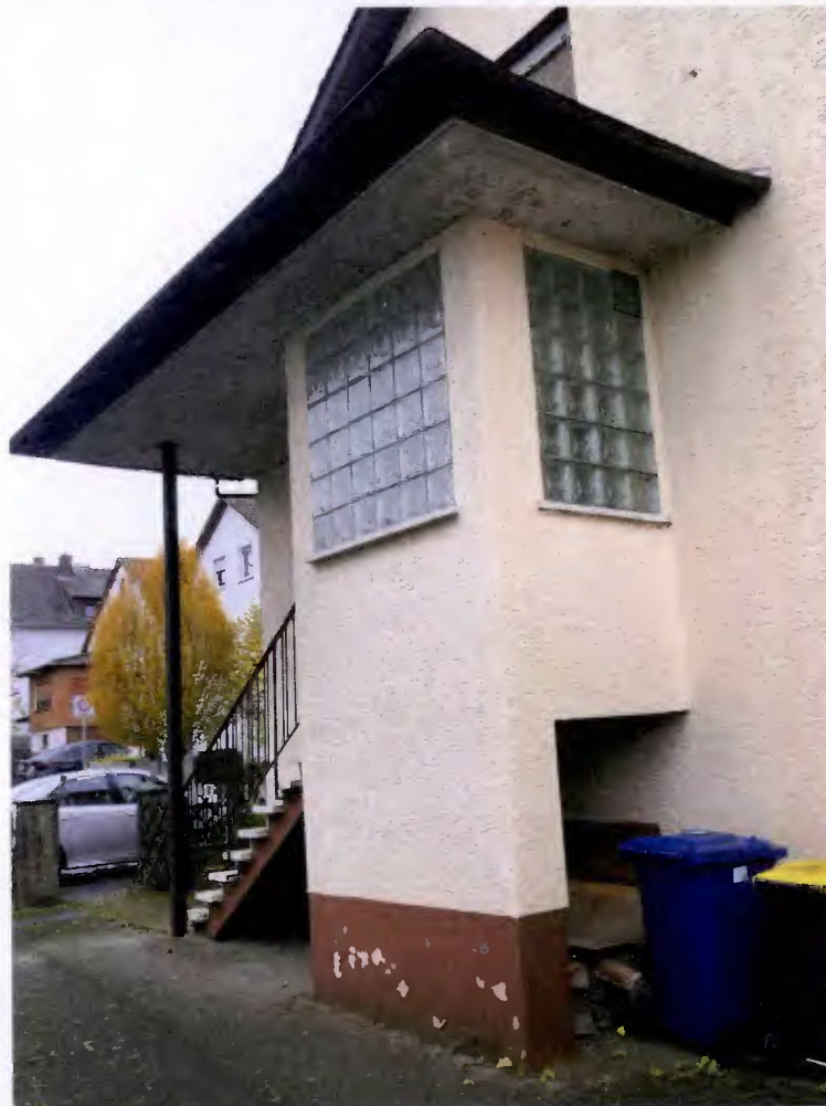
Bild 4 Eingangsbereich, Hofansicht von Nordwesten
