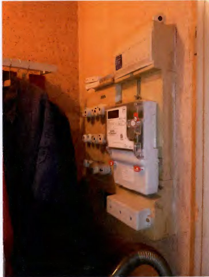
Bild 11 Elektro-Unterverteilung
