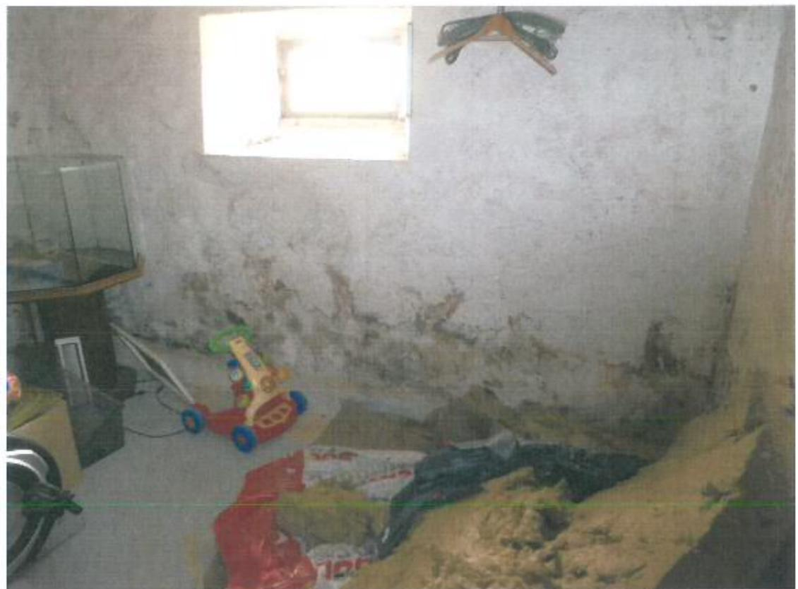
**Bild 14, Wohnhaus Kellergeschoss, Feuchtigkeit am Anschluss Boden/Wand**
