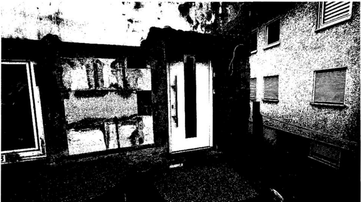
Bild B8 Hauseingangstüre
