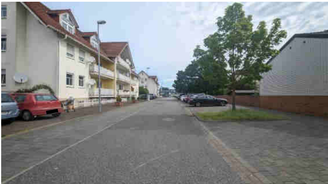
Bild A2 Blick in die Erschließungsstraße
