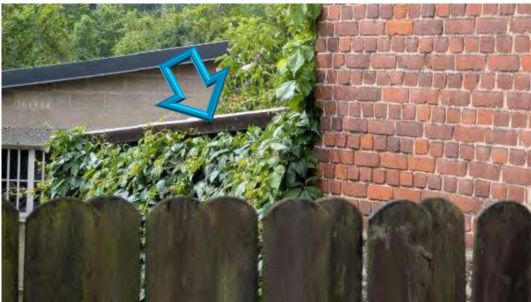
Bild B8 Beispiel Anbau
