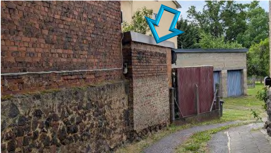
Bild B7 Beispiel Anbau
