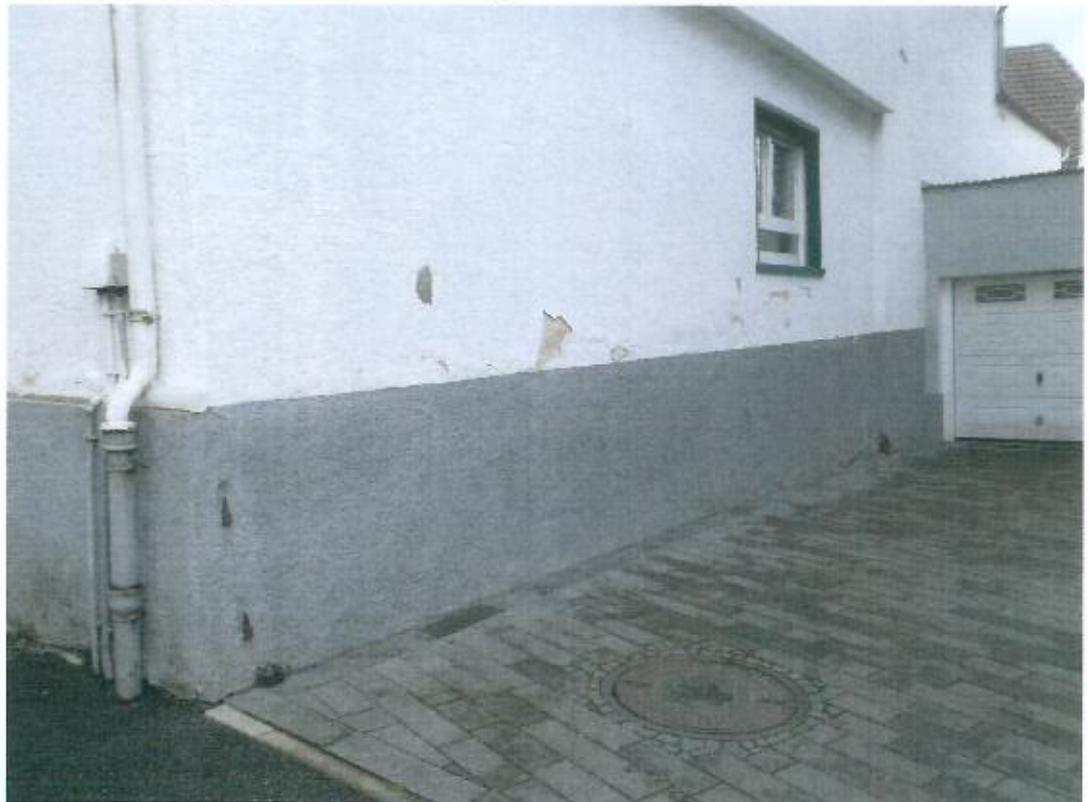
**Bild 8, Wohnhaus, Putzschäden im Sockelbereich**
