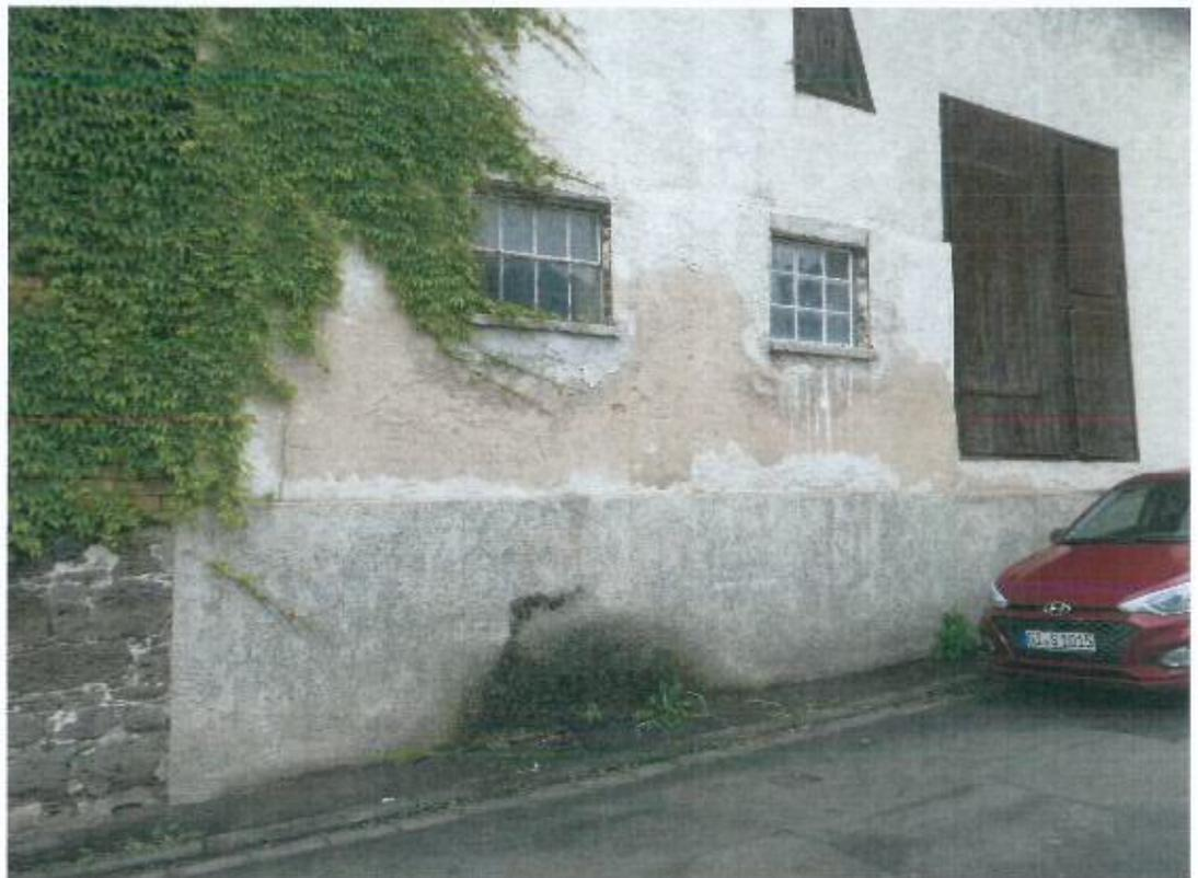
**Bild 10, Stallscheune 2, Putzschäden in Sockel- und Wandflächen**
