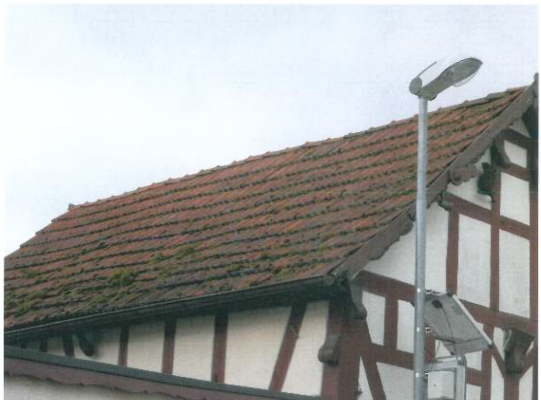
Bild 14, Stallgebäude, Schäden in der Dacheindeckung: Unregelmäßigkeiten der Dachfläche, Ortgang, Vermoosung
