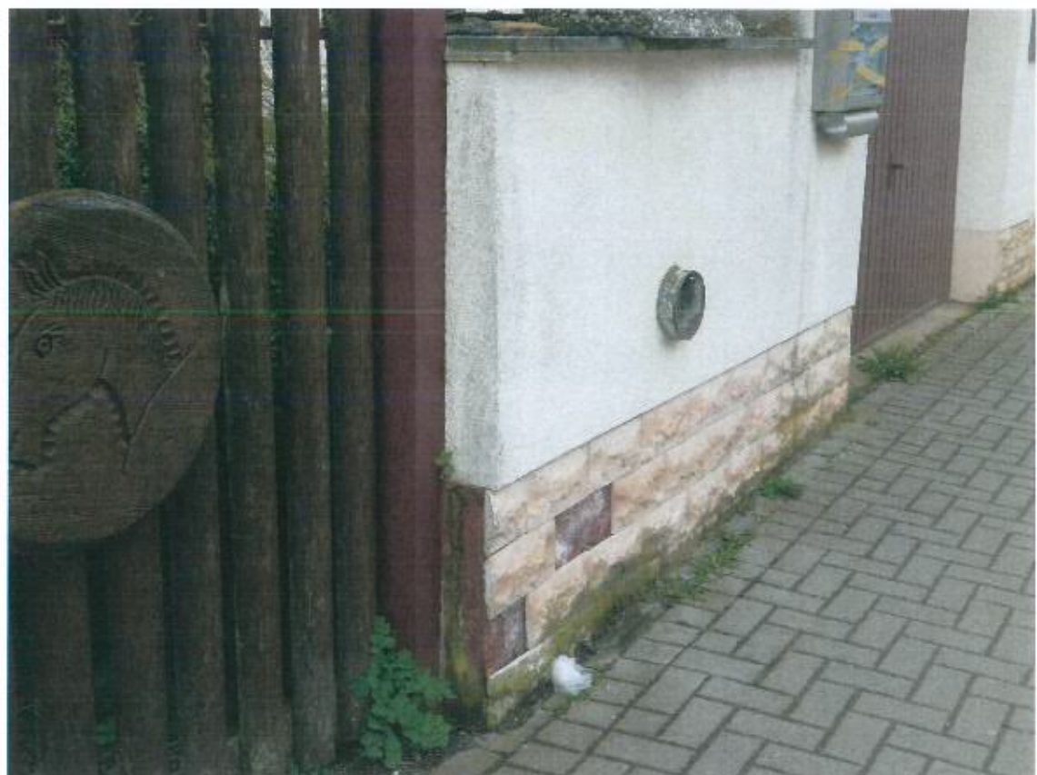
Bild 16, Garage und straßenseitige Mauer, Schäden in der Sockelbekleidung
