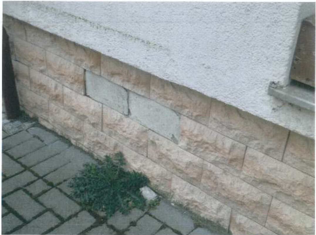
Bild 13, Wohnhaus, Schäden in der Sockelbekleidung
