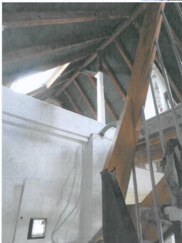
Bild 10, Dachgeschoss, Treppenaufgang zum Spitzboden
