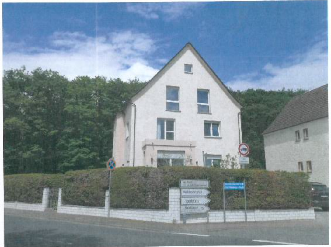
Bild 1, Wohnhaus, Straßenansicht Gießener Straße/Waldstraße von Südwesten
