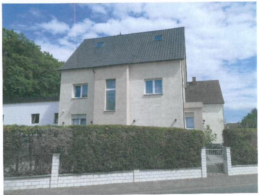
Bild 2, Wohnhaus, Straßenansicht Gießener Straße von Nordwesten
