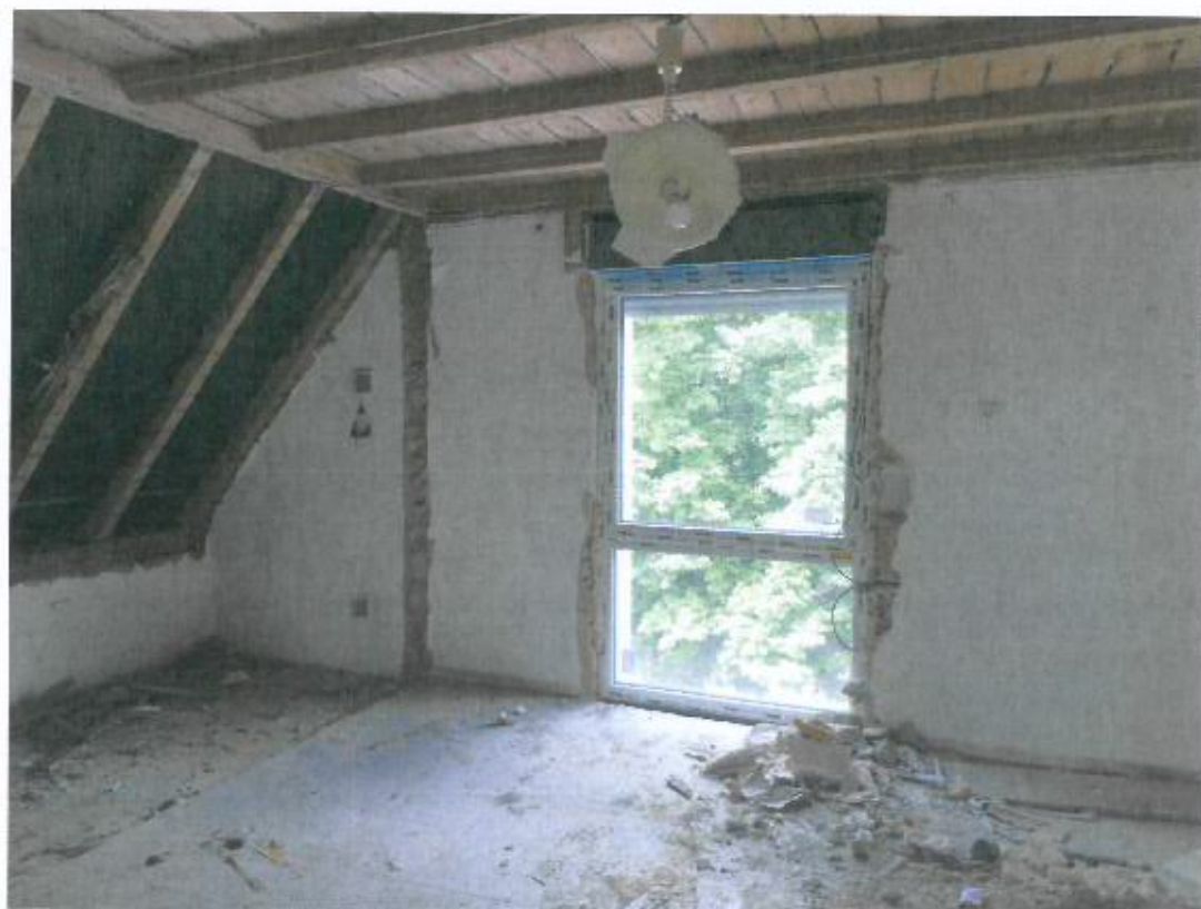
Bild 12, Dachgeschoss, Raum Nordost-Seite
