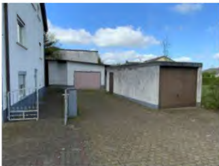
Bild 6: Garage und Fertiggarage
