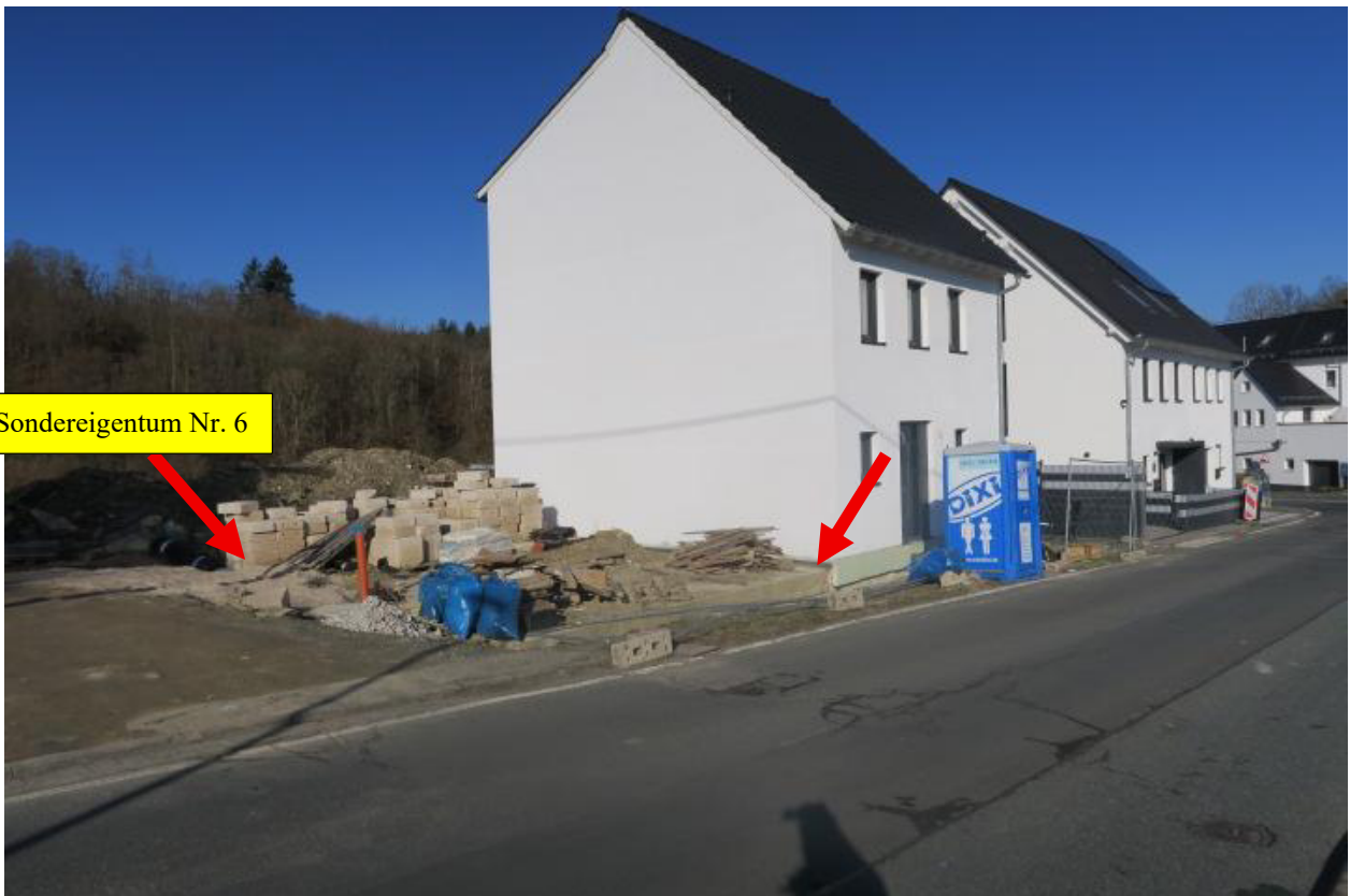
Foto 2: Ansicht des Grundstücks von der Parkstraße von Südosten
