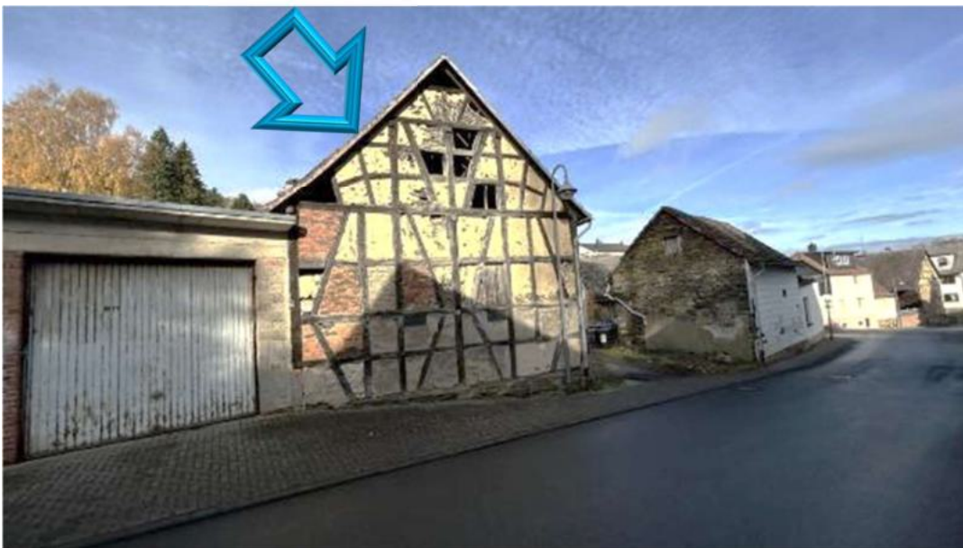
Bild B8 Scheune
