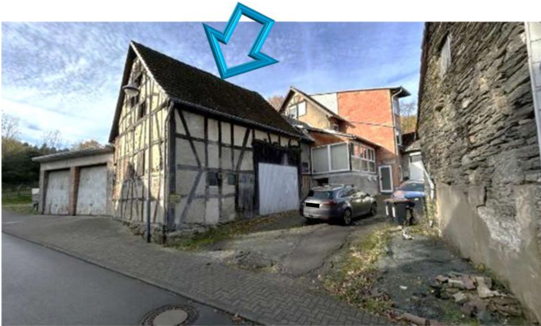
Bild B7 Scheune
