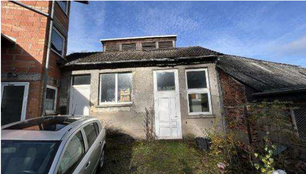
Bild B5 Nebengebäude
