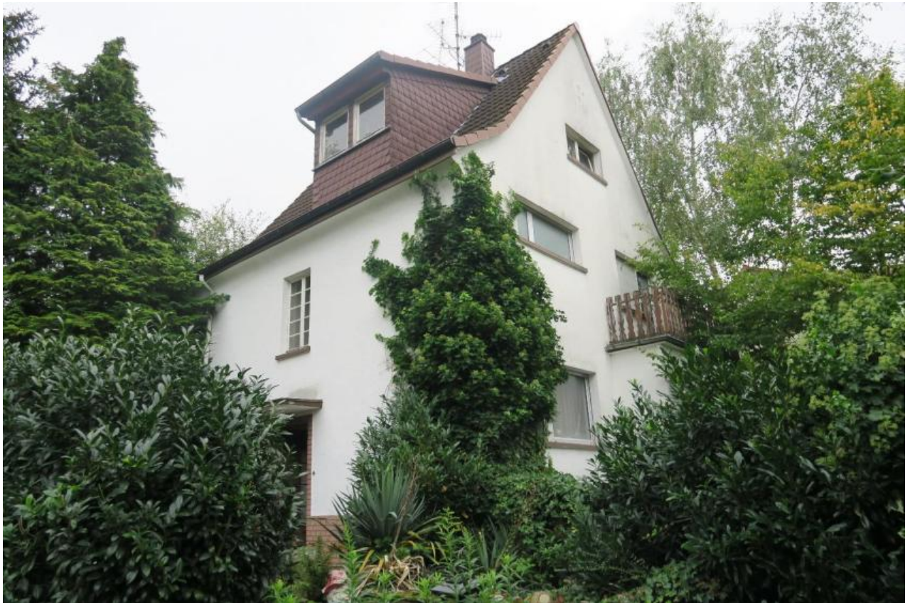
Foto1: Ansicht des Wohnhauses von Westen
