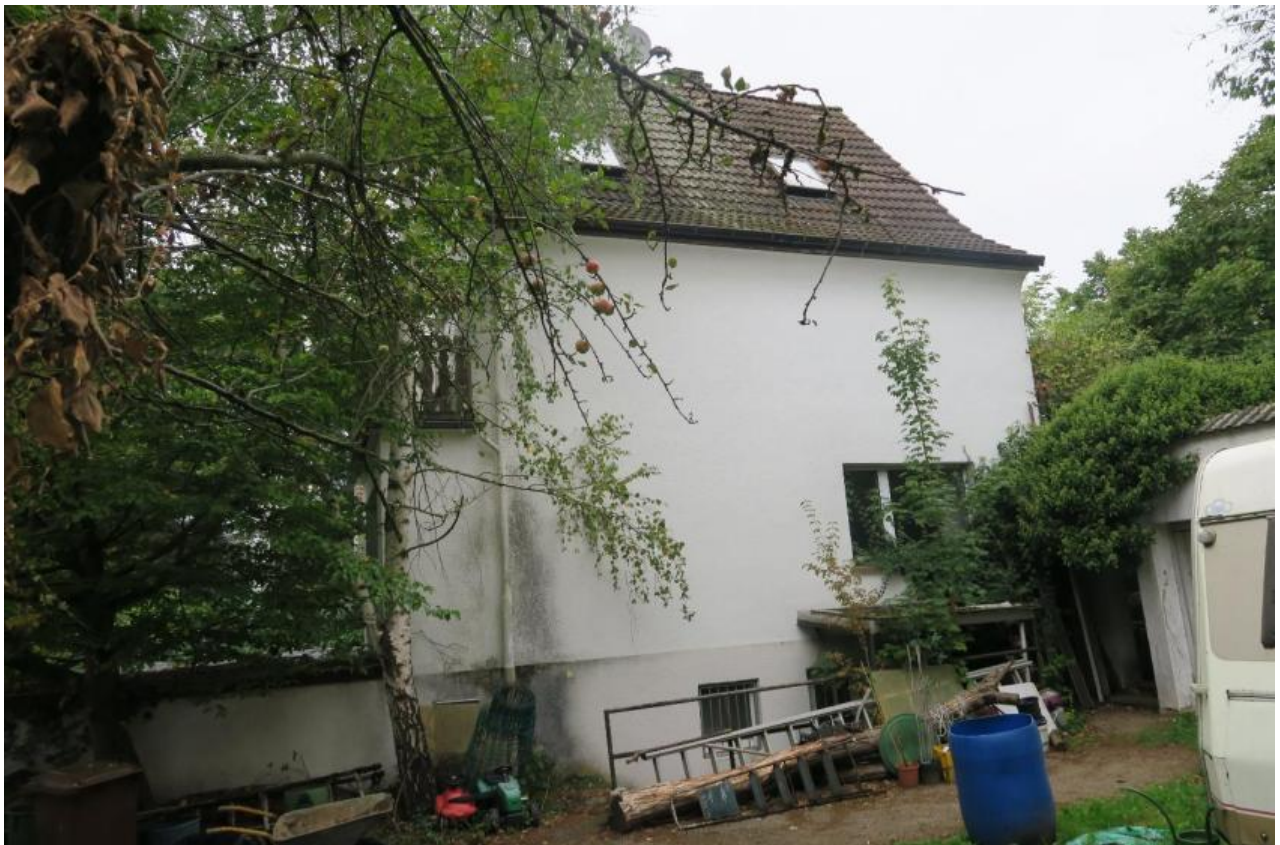
Foto 2: Ansicht des Wohnhauses von Süden
