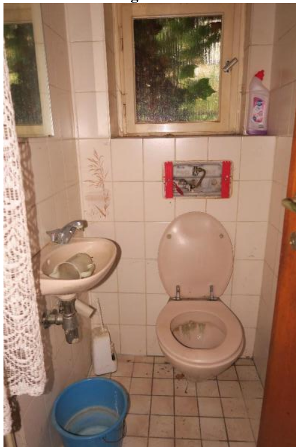
Foto 8: WC im Erdgeschoss
