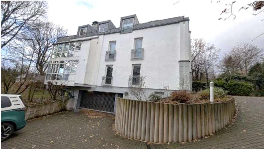
Bild B3 exemplarische Gebäudeansicht
