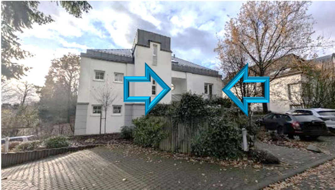
Bild B1 exemplarische Gebäudeansicht
