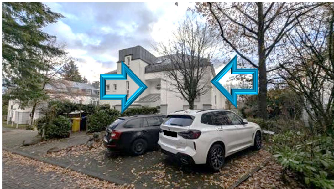
Bild B2 exemplarische Gebäudeansicht
