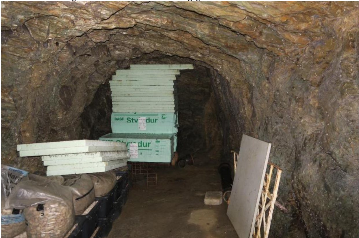
Foto 6: Natursteingewölbe unter dem Bewertungsgrundstück
