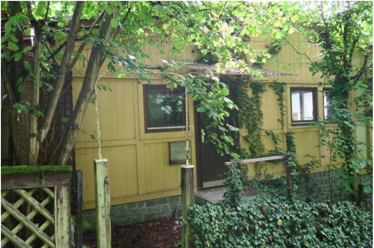
Foto 2: Ansicht des Wohnhauses von der Straße von Nordwesten
