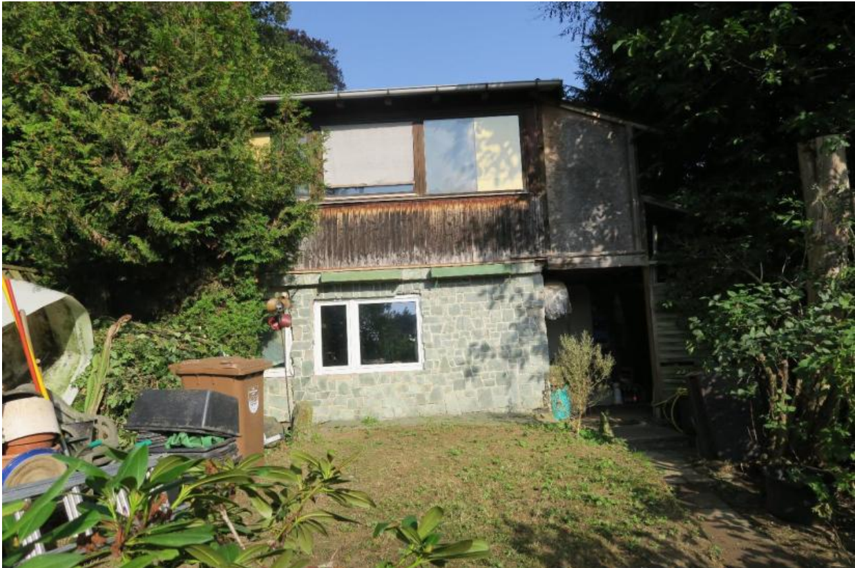
Foto 3: Ansicht des Gebäudes von Süden
