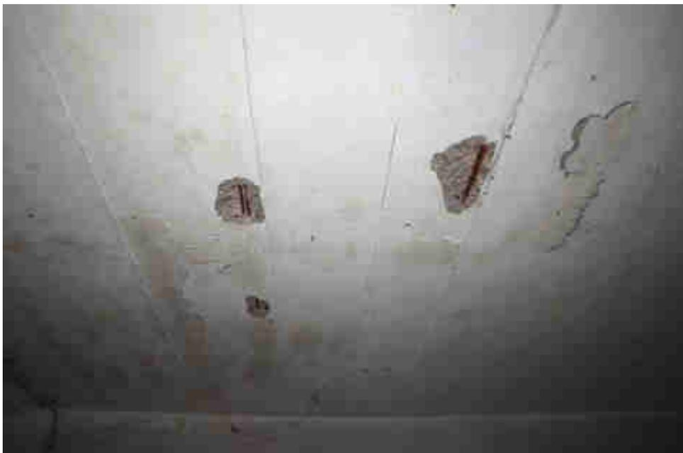
Bild E2 Schäden Tiefgarage
