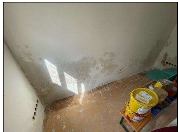
EG Mittelweg 18 – Feuchtigkeitsschaden
