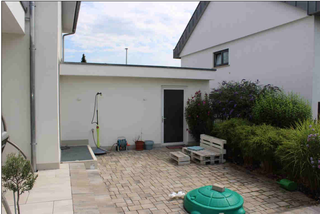
Bild B7: Rückansicht Garage
