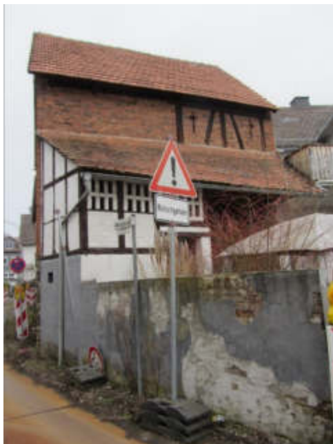
Bild 6: Anbau an Scheune, Nebengebäude/ Lager
