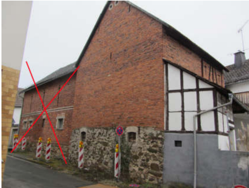
Bild 7: Ansicht West, Scheune
