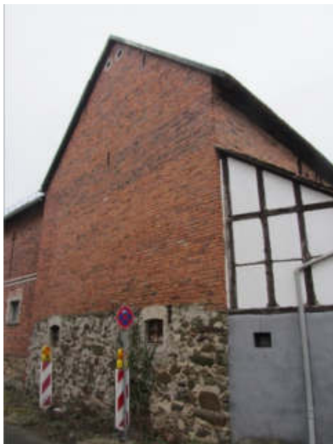
Bild 8: Ansicht West, Scheune
