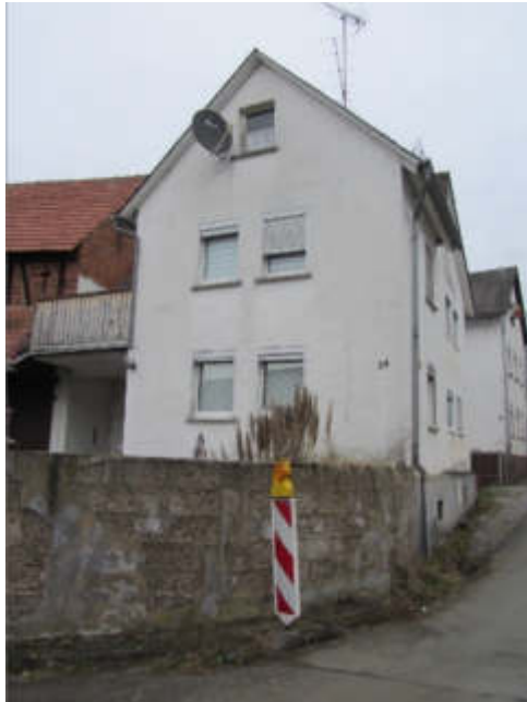
Bild 5: Ansicht Südwest, Wohngebäude
