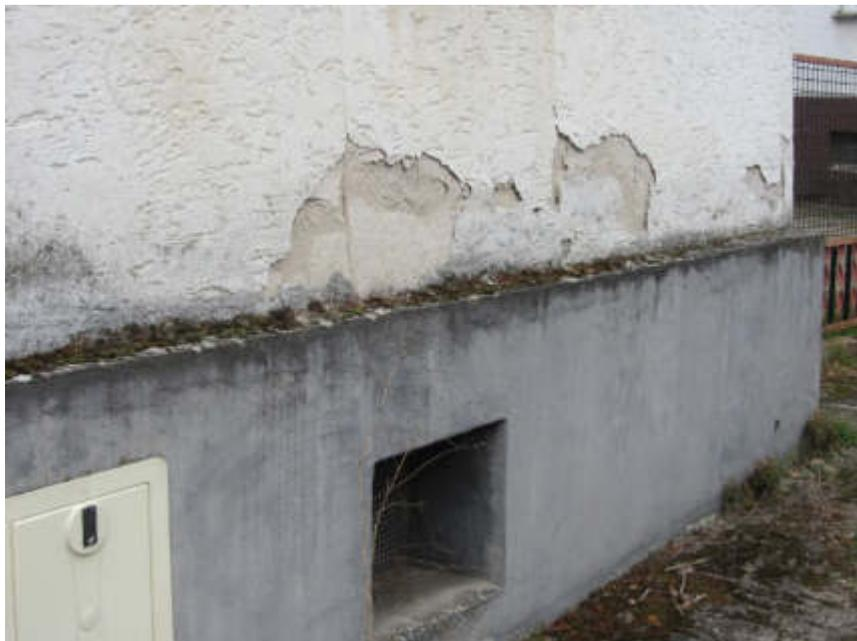
Bild 12: Zustand Fassaden, Putzschäden
