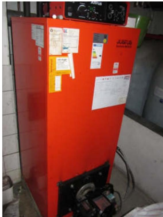
Bild 42: Kellergeschoss: Öl- Zentralheizung
