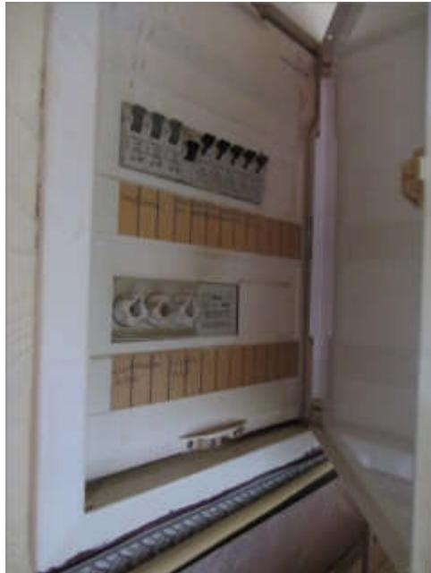
Bild 33: Elektronterverteiler
