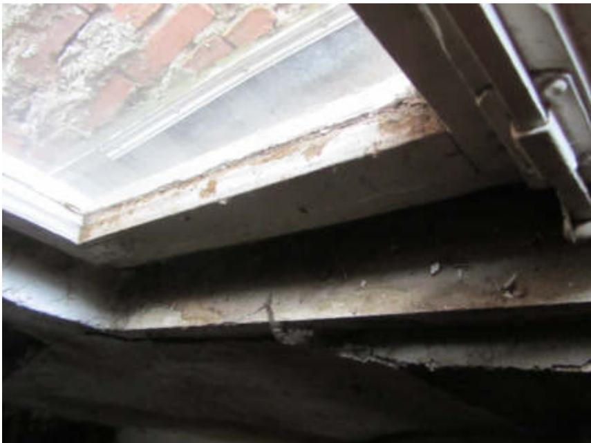
Bild 40: Dachgeschoss: Zustand Holzfenster
