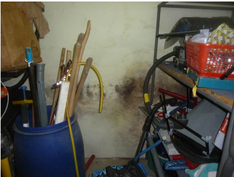
Bild 10: Ansicht Feuchtigkeit / Schimmel Keller:
