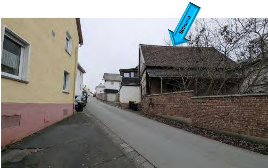
Bild A2 Blick in die Erschließungsstraße mit Blick auf die Scheune
