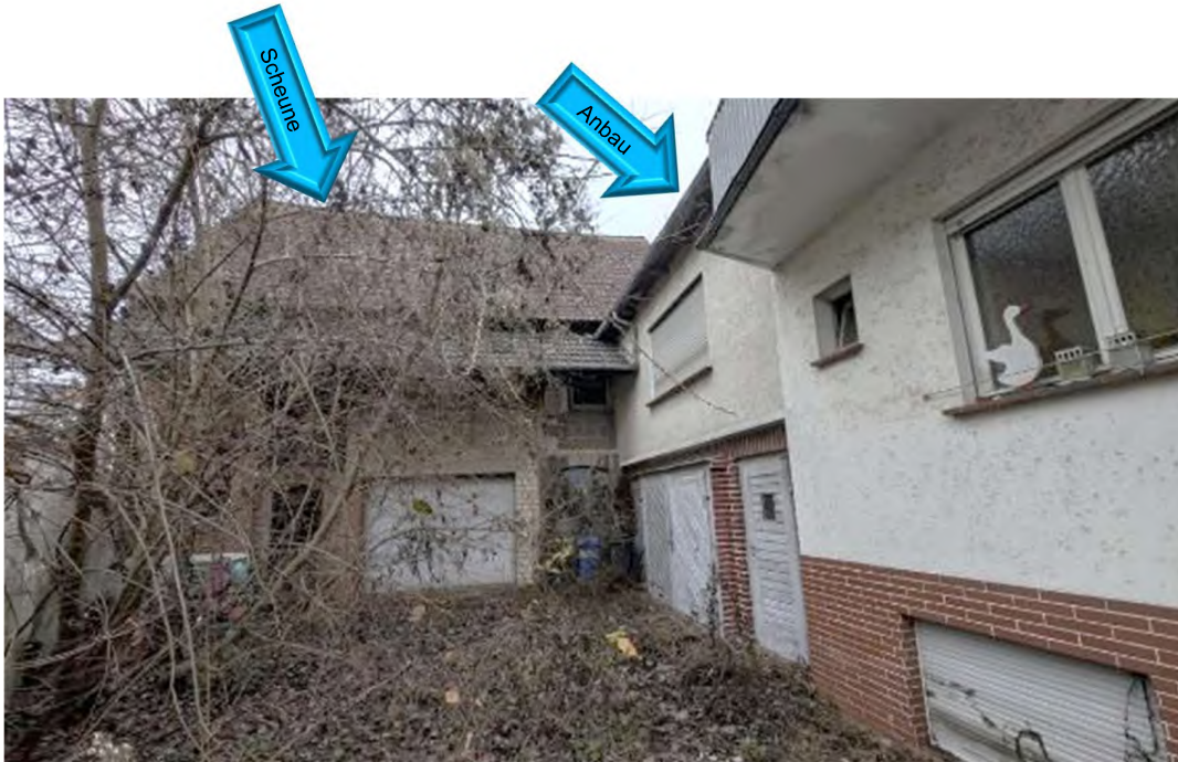
Bild B3 Hofansicht mit Blick auf Scheune und Wohnhausanbau
