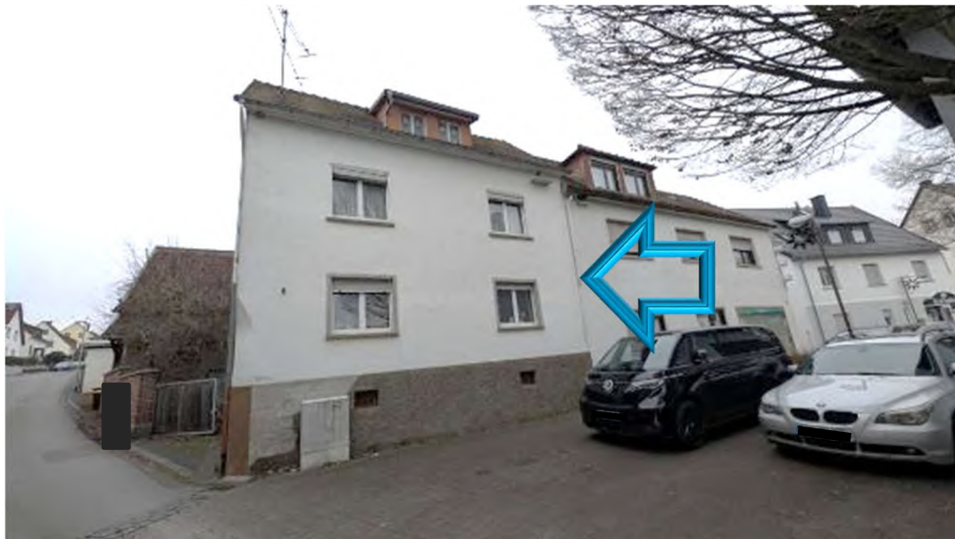
Bild B2 exemplarische Ansicht Wohnhaus – Blick von Süden
