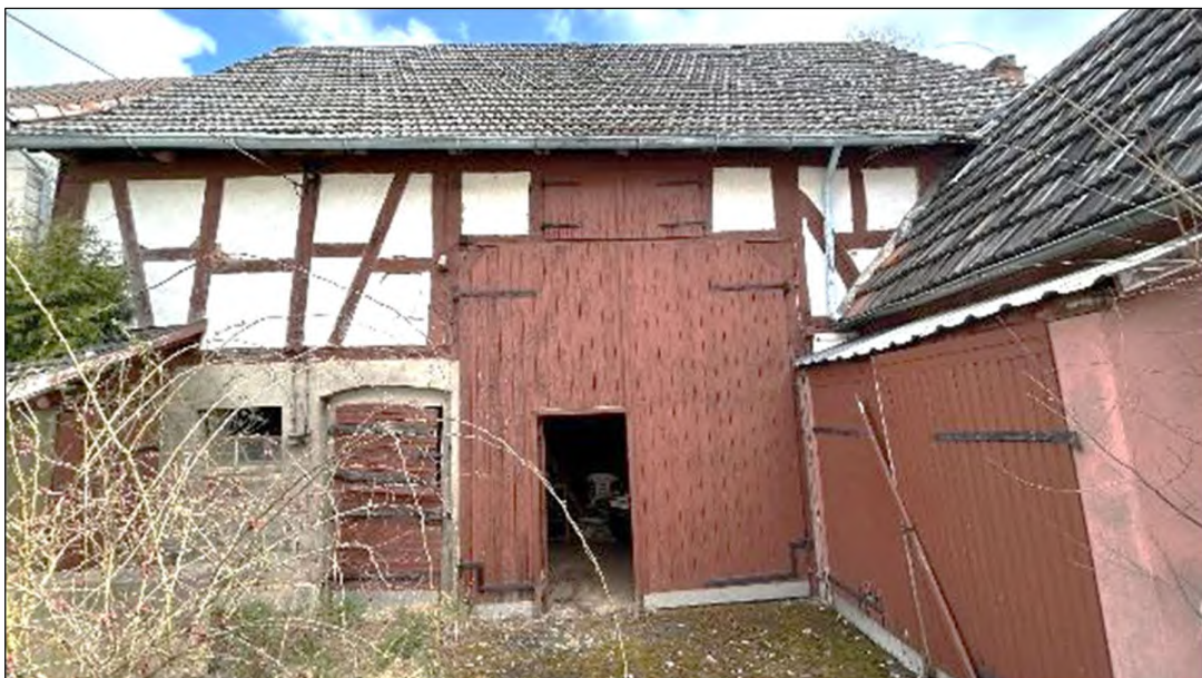
Bild B6: Scheune (Beispiel)
