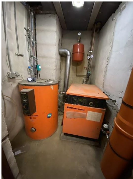
Heizung mit nebenstehendem Warmwasserspeicher
