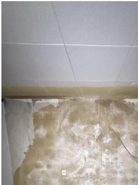
Raum im EG mit einer durch Feuchtigkeit geschädigten Außenwand. Die Ursache des Feuchtigkeitseintritts wurde gemäß Mitteilung im Ortstermin zwischenzeitlich behoben.
