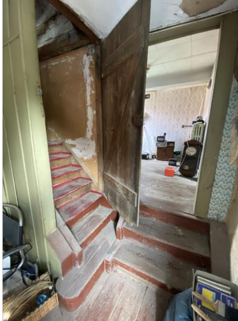
Treppe zum nicht ausgebauten Dachraum
