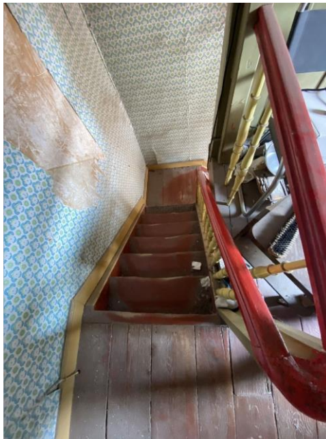
Treppe vom Obergeschoss zum Erdgeschoss
