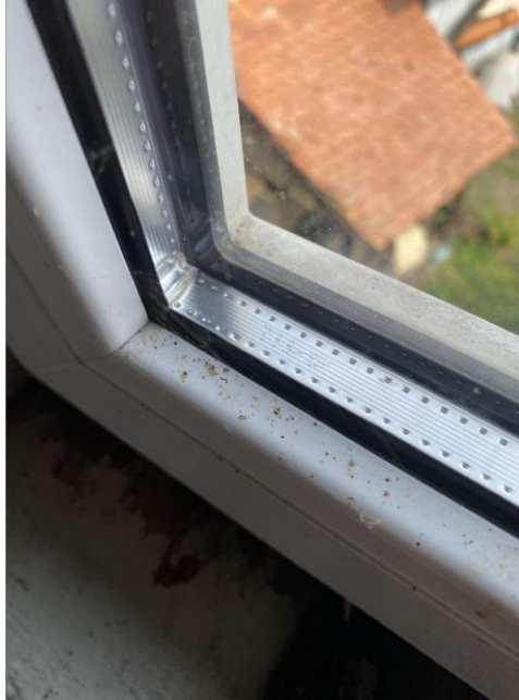
Fenster erneuert ca. im Jahr 2001
