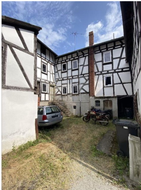
Blick auf das Wohnhaus. Die Gebäudeecke am linken Bildrand gehört zu einem Nachbargebäude
