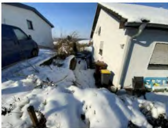
Bild 6: Zugang Eingang UG
