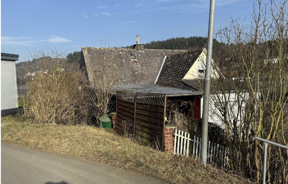
Westansicht (von der Straße "Auf der Hohl")
