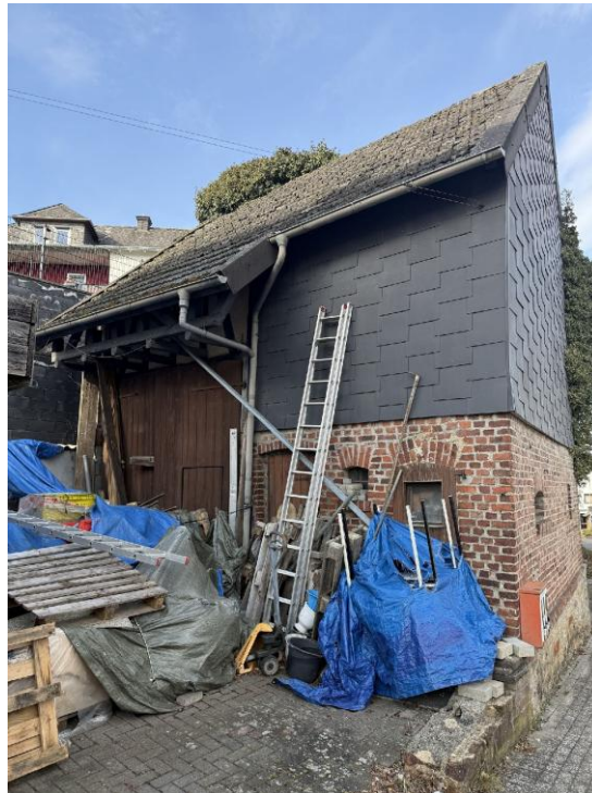
Ansicht Hof und Nebengebäude
