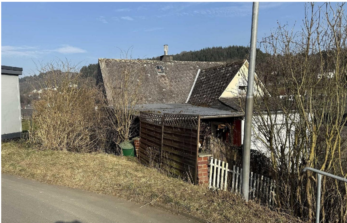
Ansicht des Bewertungsgrundstücks von der Straße „Auf der Hohl“
