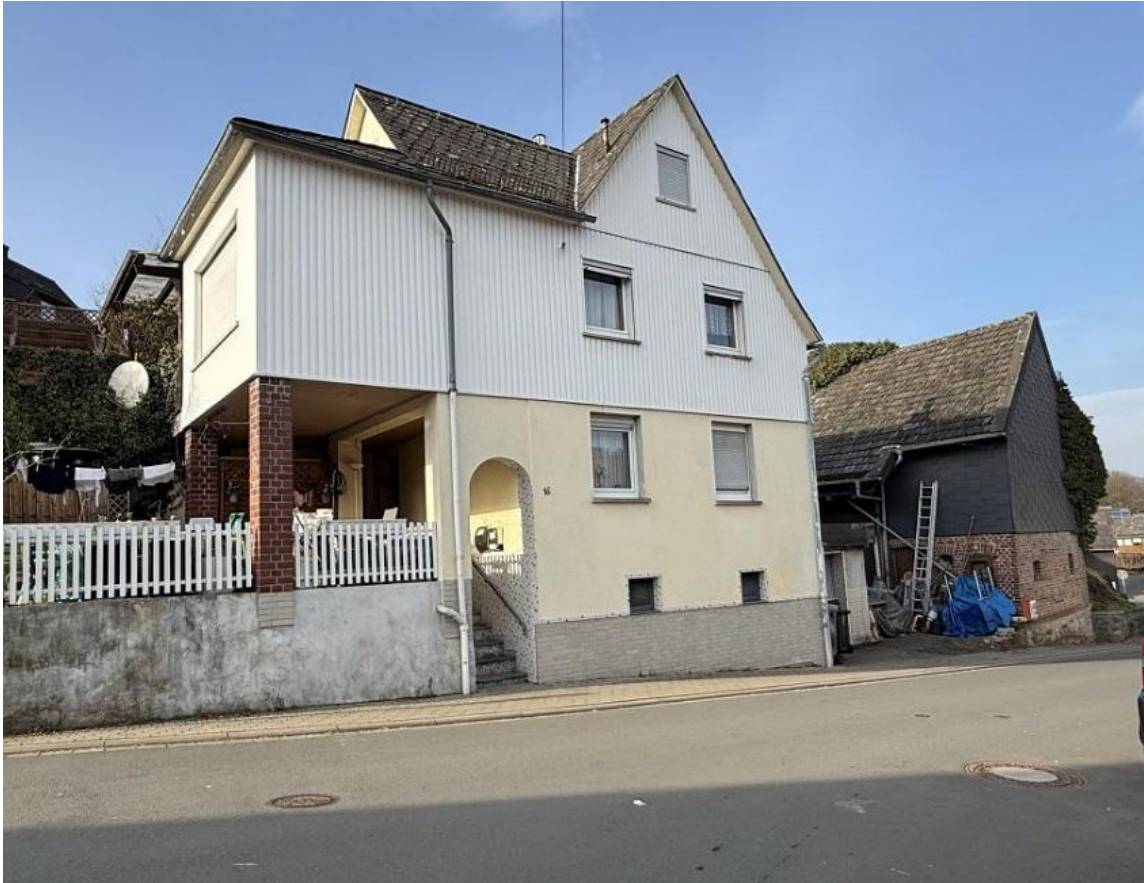
Ansicht des Bewertungsgrundstücks von der Bahnhofstraße
