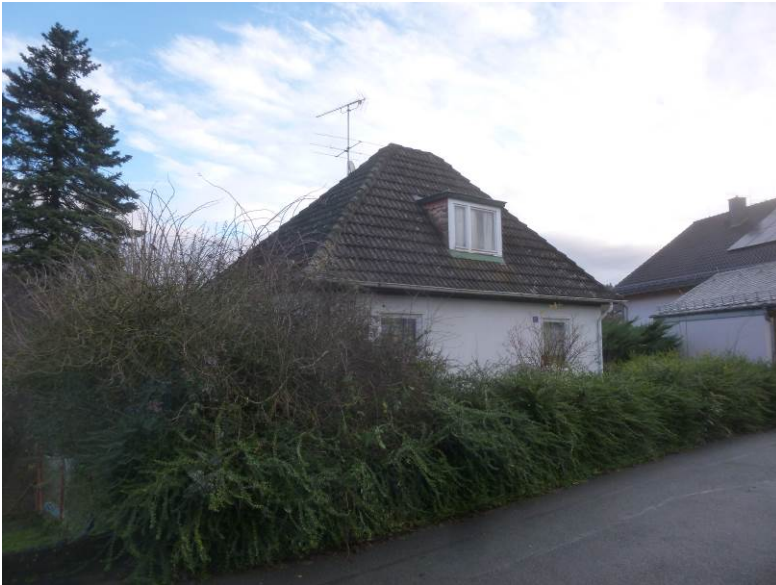
Bild 1: Ansicht von Südwesten:
