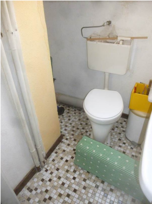
Bild 5: Ansicht Bad DG:
