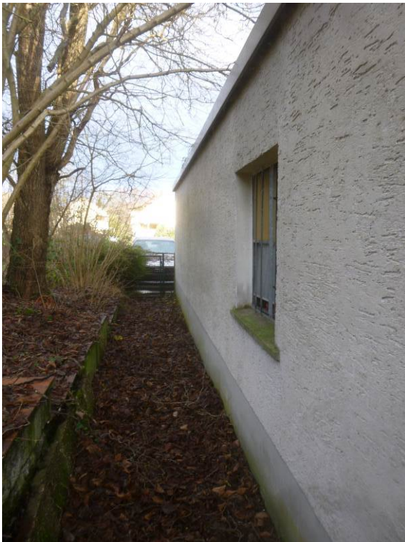
Bild 2: Ansicht Zugang Geräteraum / Garage:
