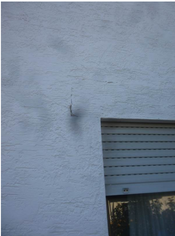
Bild 6: Ansicht Risse an der Fassade:
