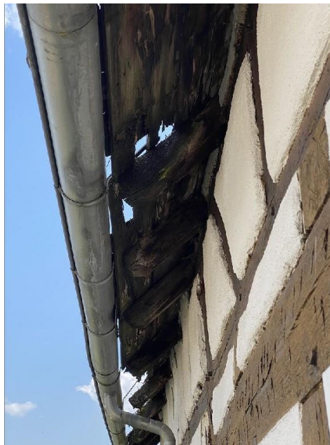
Schadhafte Holzschalung im Bereich der Dachtraufe des Wohngebäudes
