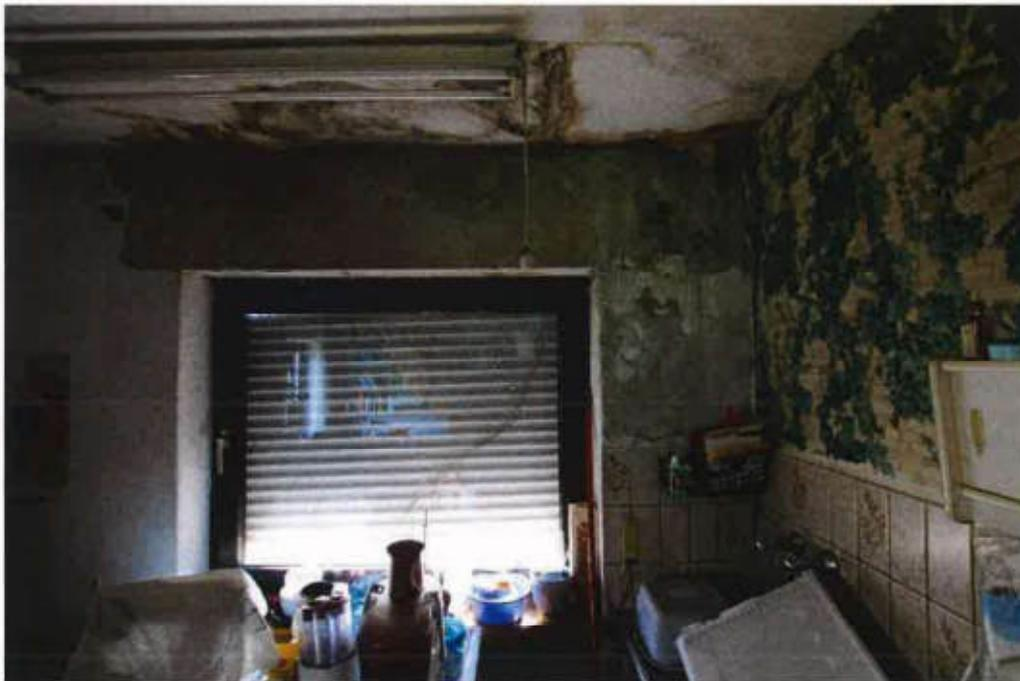
Feuchteschaden im EG durch undichtes Dach (repariert)
