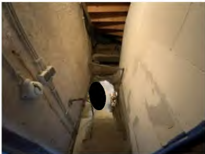
Bild 33: Treppe KG - EG
