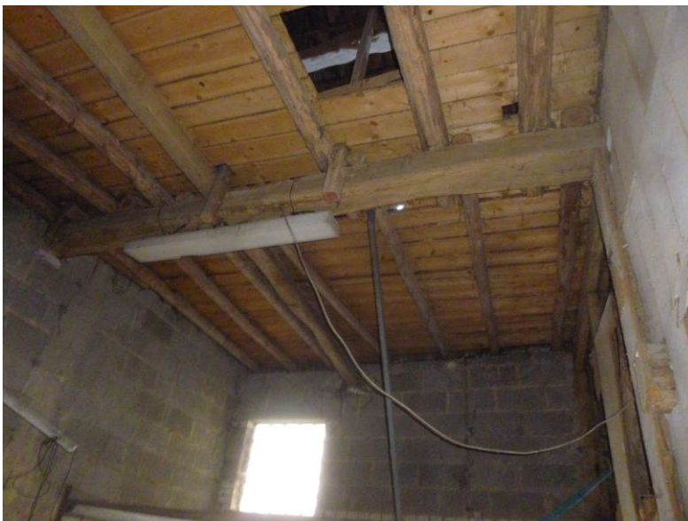
Bild 2: Ansicht Decke / 2. Ebene:
