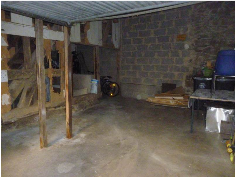
Bild 1: Ansicht Scheune / Garage:
